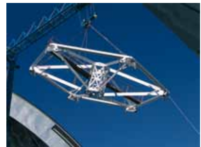
Introducción de la araña del espejo secundario a través de la compuerta de observación.
