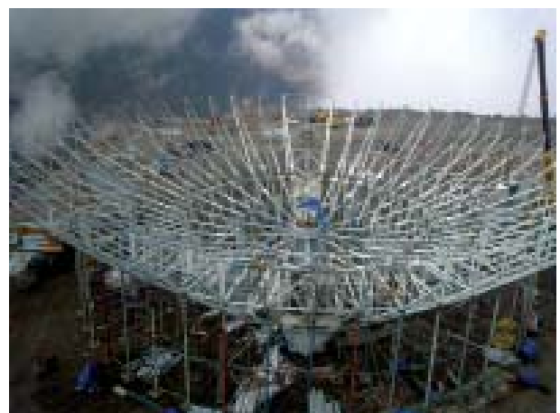
Alineamiento del reflector del GTC, abril 2004. Foto: GTM.
