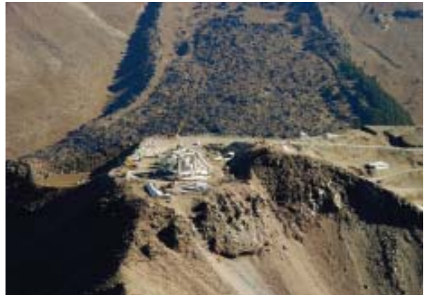
Vista aérea del sitio del GTM. Foto: GTM.
