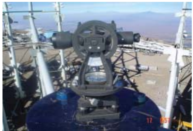
Instrumento de medida utilizado durante el montaje de la estructura del GTM. Foto: GTM.
