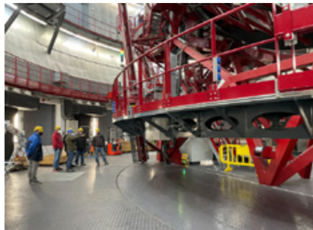
Nueva plataforma de mantenimiento para el GTC e imágenes de su instalación. Dará servicio a los focos Folded Cassegrain (izquierda) y a la estación focal Cassegrain (derecha).
