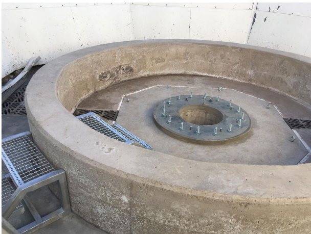
Cimiento del TMS.
