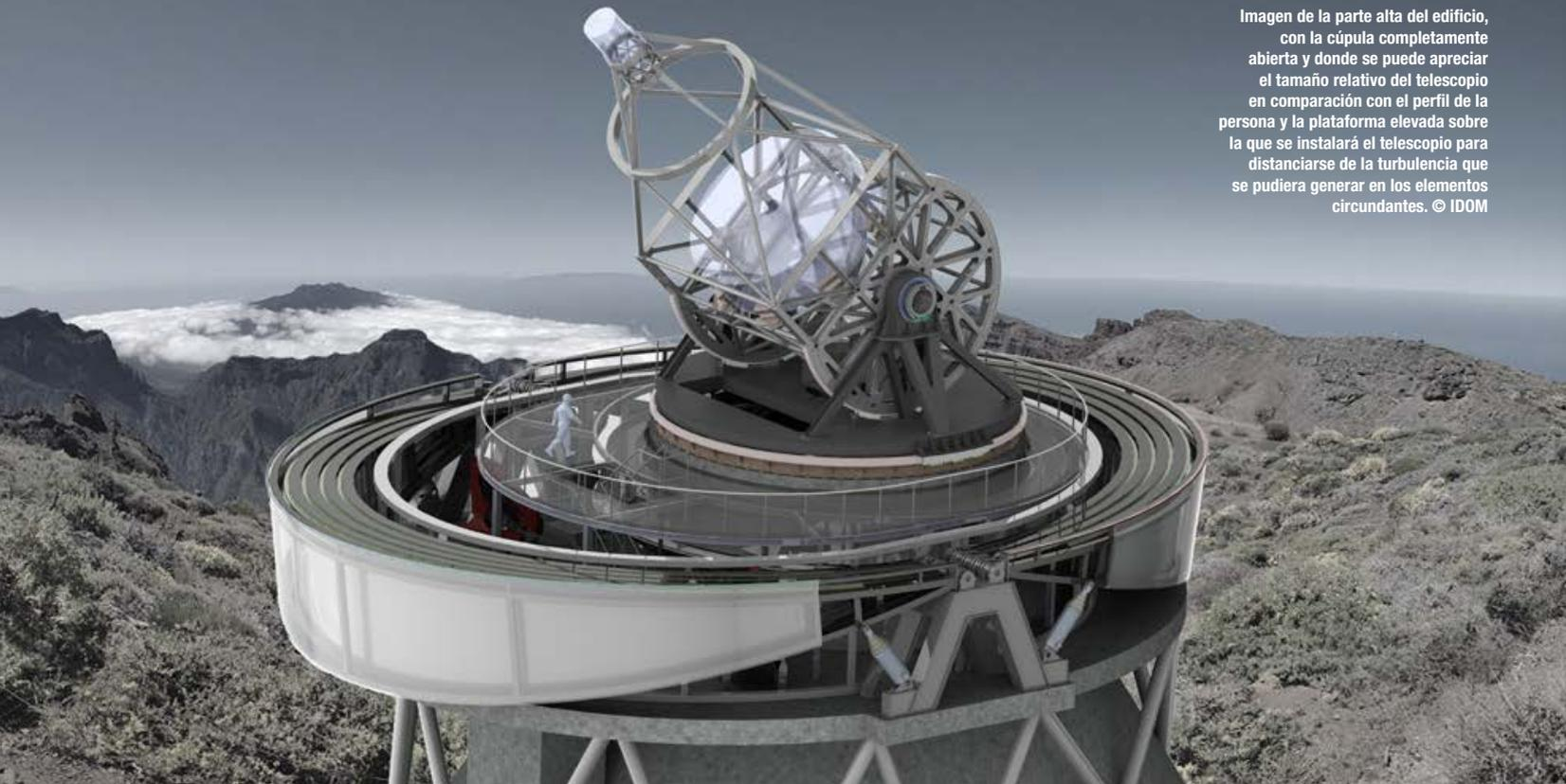
Imagen de la parte alta del edificio, con la cúpula completamente abierta y donde se puede apreciar el tamaño relativo del telescopio en comparación con el perfil de la persona y la plataforma elevada sobre la que se instalará el telescopio para distanciarse de la turbulencia que se pudiera generar en los elementos circundantes. © IDOM
